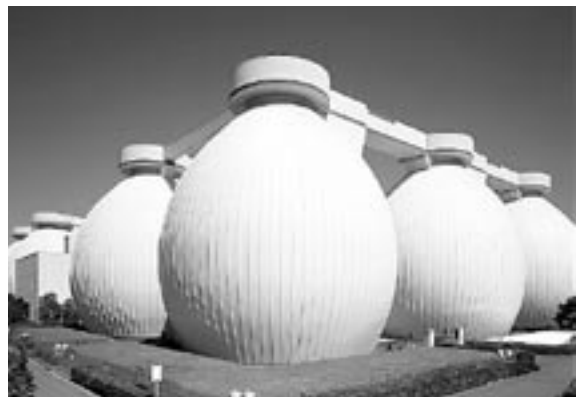
■北部汚泥資源化センター
