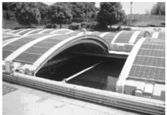
■ろ過池の太陽光発電システム
