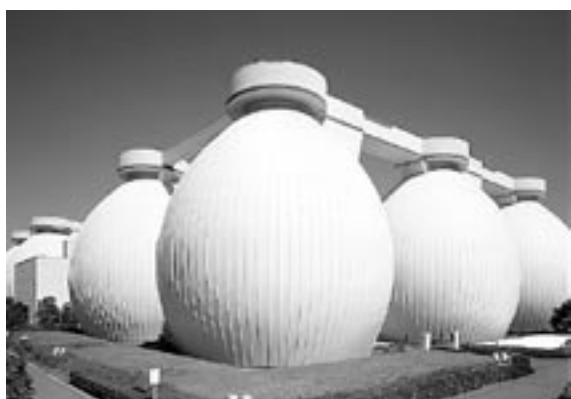
■消化タンク 北部汚泥資源化センター（鶴見区）
