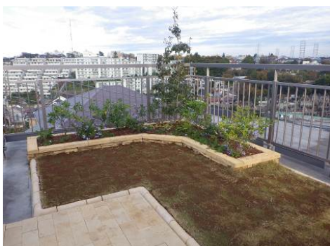
民有地(屋上)緑化事例(鶴見区)
