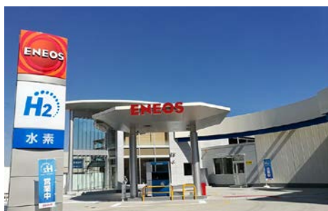
横浜綱島水素ステーション
