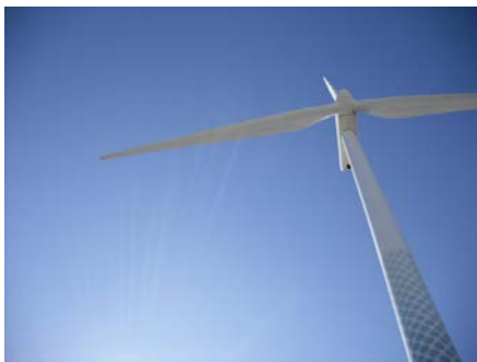
横浜市風力発電所「ハマウイング」
