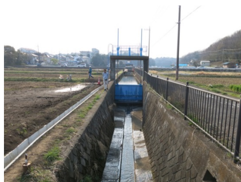
整備された水路(青葉区寺家町)
