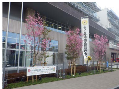
公共施設での緑の創出事例(港南区庁舎)
