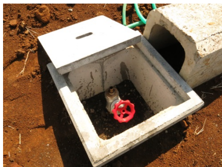
「立上り水栓の設置」(都筑区池辺町)
