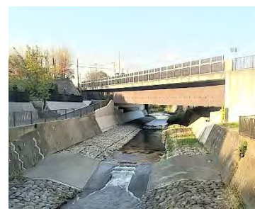
和泉川における河川改修（泉区）
