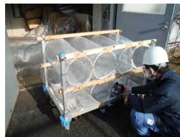
アスベスト除去工事での立入検査の様子
