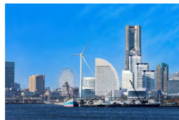
横浜市風力発電所（ハマウイング）
