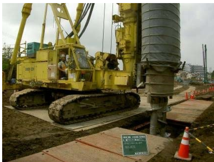
写真 3.3.2-1 環境保全のための措置の実施状況（止水性の高い連続壁の設置）
