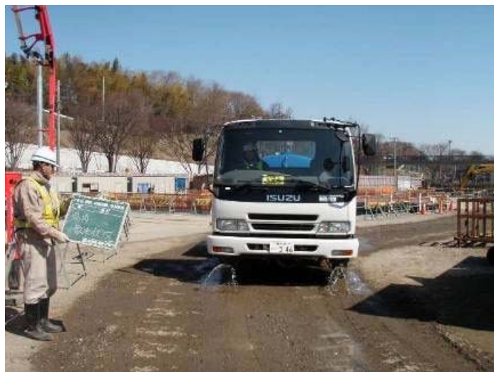
写真 4-3 環境保全のための措置の実施状況（工事現場での散水や清掃②）
