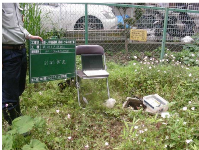
写真 3.3.2-2 環境保全のための措置の実施状況（地下水位の観測）
