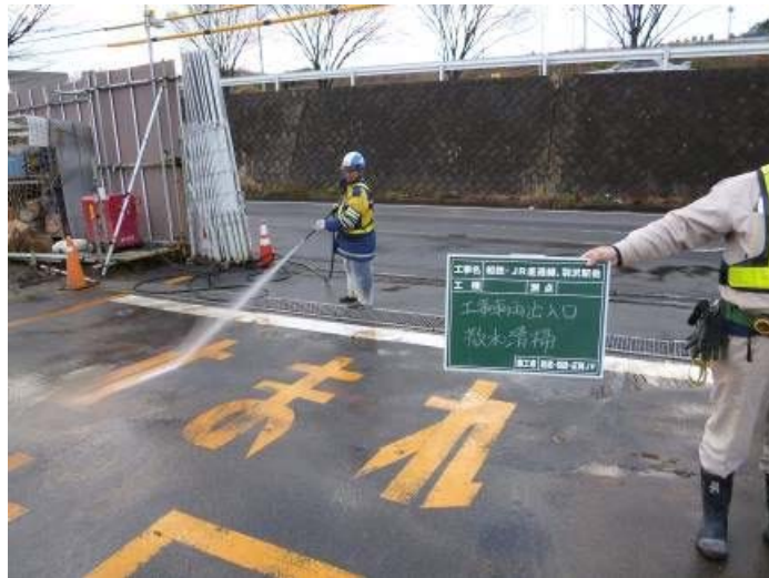
写真 4-2 環境保全のための措置の実施状況（工事現場での散水や清掃①）
