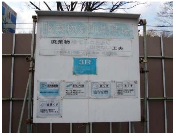
写真 3.3.3-1 環境保全のための措置の実施状況（建設廃棄物の分別処理）
