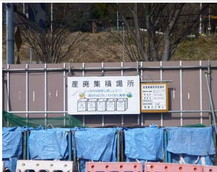
写真 3.3.5-1 環境保全のための措置の実施状況（建設廃棄物の分別処理）
