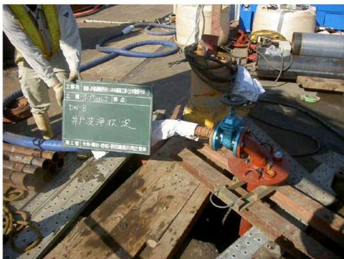
写真 3.3.4-3 環境保全のための措置の実施状況（ディープウェル工法）
