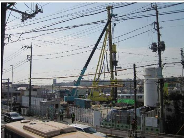
写真 3.3.4-1 環境保全のための措置の実施状況（止水性の高い連続壁の設置）
