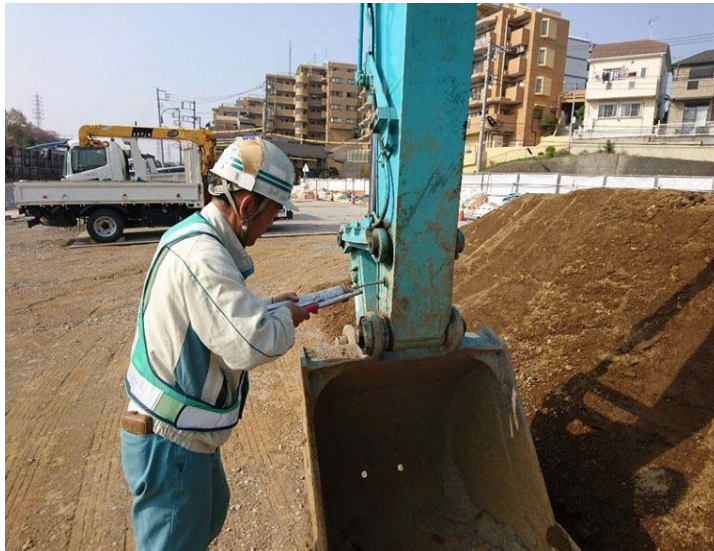
写真 4-5 環境保全のための措置の実施状況（定期点検・整備）
