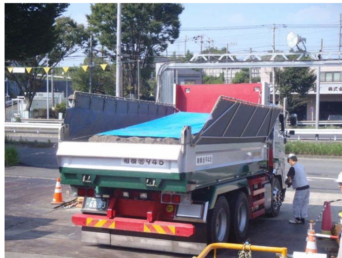
写真 4-3 環境保全のための措置の実施状況（工事用車両の荷台への防塵シートの敷設）
