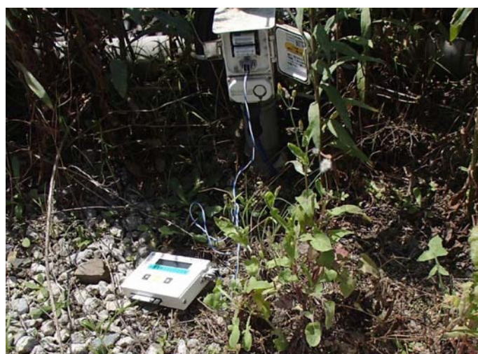
写真 3.3.2-1 環境保全のための措置の実施状況（地下水位の観測）
