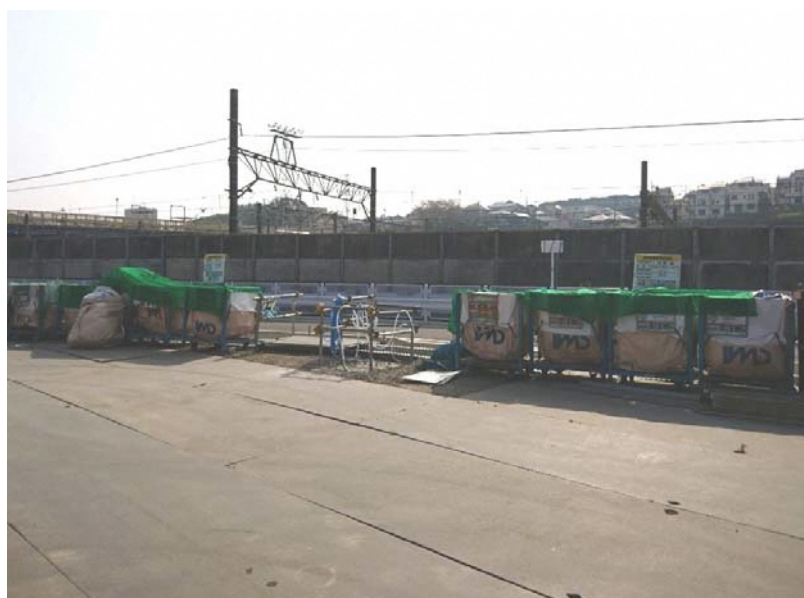
写真 3.3.3-1 環境保全のための措置の実施状況（建設廃棄物の分別処理）
