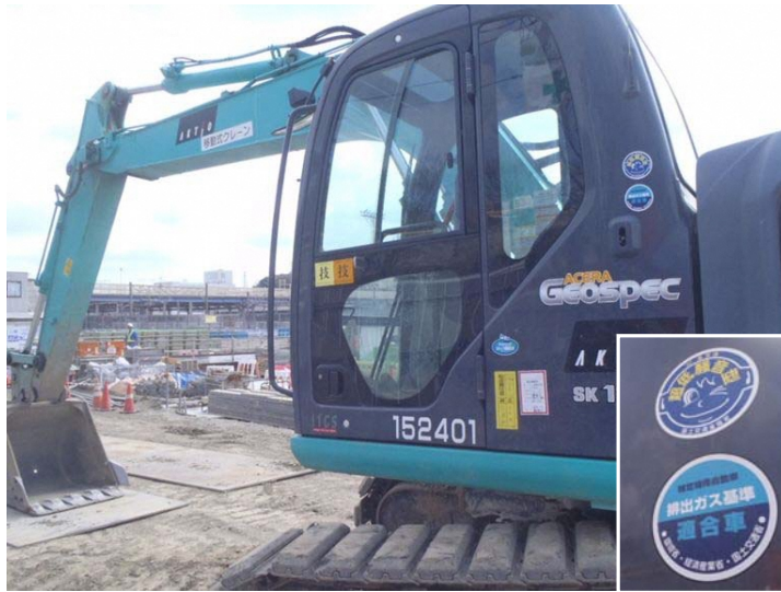
写真 4-4 環境保全のための措置の実施状況（環境対策型建設機械の使用）
