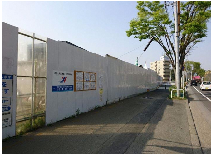
写真 4-1 環境保全のための措置の実施状況（仮囲いの設置）
