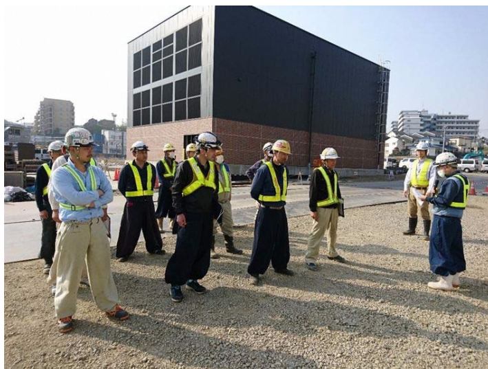
写真 4-6 環境保全のための措置の実施状況（安全教育）
