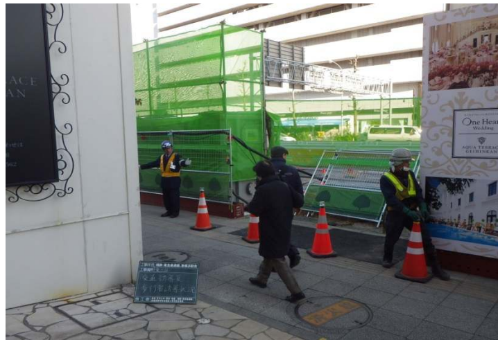
写真 2.4.4-8(1) 環境保全のための措置の実施状況（通行者の誘導）
