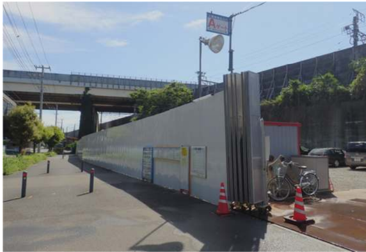
写真 2. 4. 4-1 (1) 環境保全のための措置の実施状況 (仮囲いの設置①)
