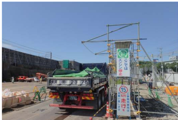
写真 2. 4. 4-3 環境保全のための措置の実施状況（工事用車両の荷台への防塵シートの敷設）
