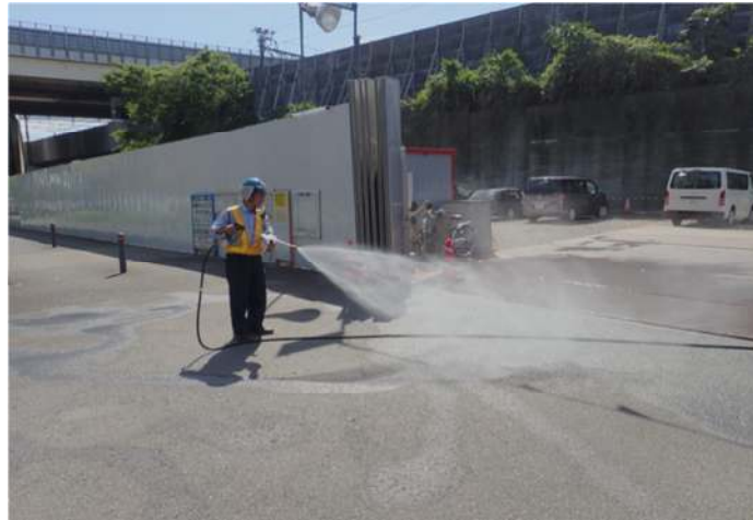
写真 2.4.4-2(1) 環境保全のための措置の実施状況（工事現場での散水）
