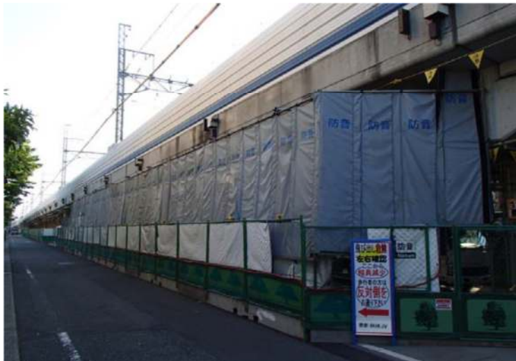
写真 2. 4. 4-1 (3) 環境保全のための措置の実施状況 (防音シートの設置)
