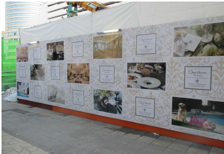
写真 2. 4. 4-1 (2) 環境保全のための措置の実施状況 (仮囲いの設置②)
