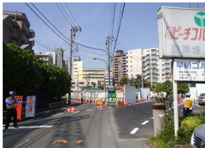
写真 2.4.4-8(2) 環境保全のための措置の実施状況（迂回路の案内・通行者の誘導）
