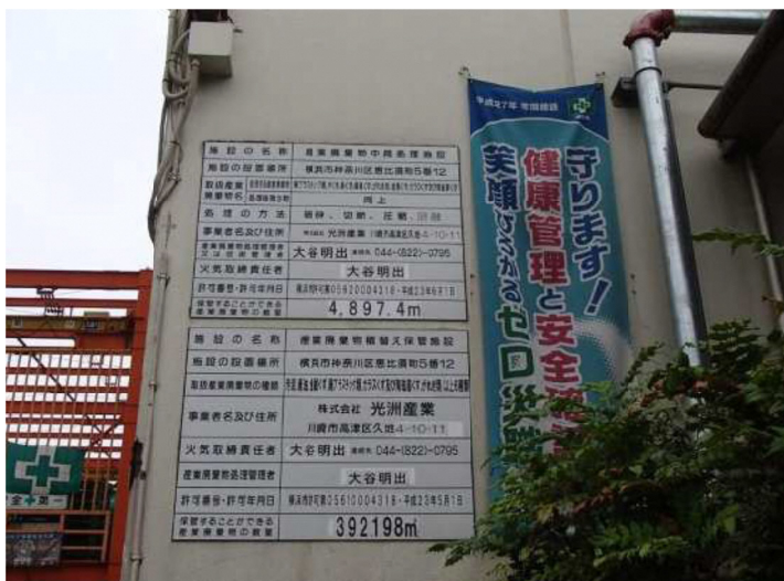
写真 2. 4. 3-1(2) 環境保全のための措置の実施状況 (再資源化処理施設への運搬①)
