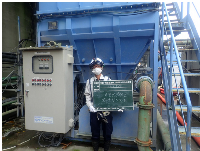
写真 2. 4. 4-6 環境保全のための措置の実施状況（濁水処理設備による排水処理）
