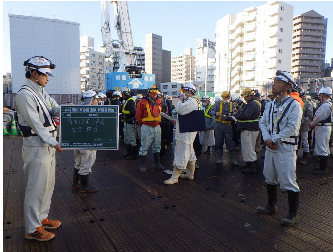
写真 2.4.4-7(1) 環境保全のための措置の実施状況（安全・環境教育、指導①）
