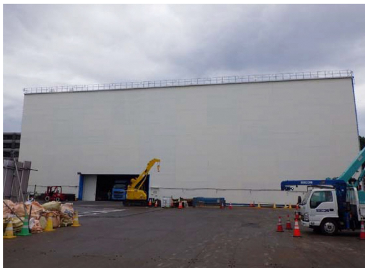
写真 2. 4. 4-1 (3) 環境保全のための措置の実施状況（防音ハウスの設置）
