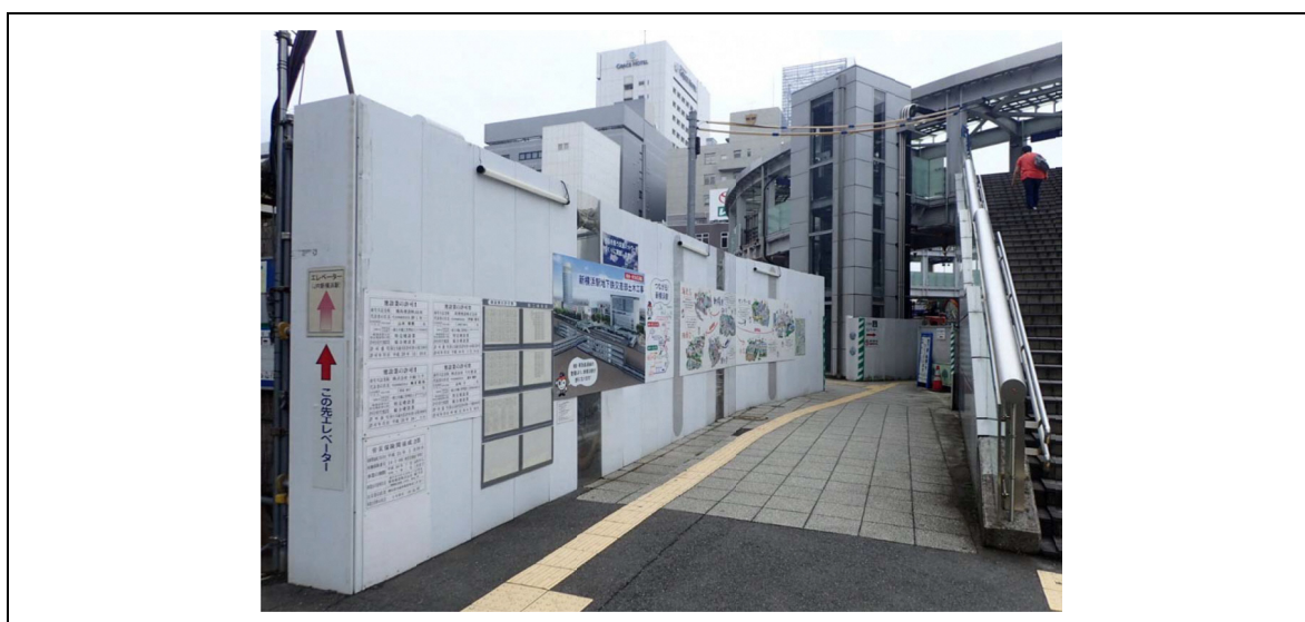
写真 2. 4. 4-1 (1) 環境保全のための措置の実施状況 (仮囲いの設置)
