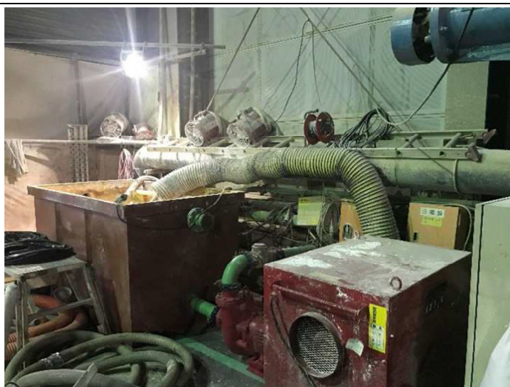
写真 2. 4. 4-1 (4) 環境保全のための措置の実施状況（粉塵発生作業時の除塵装置の稼働）
