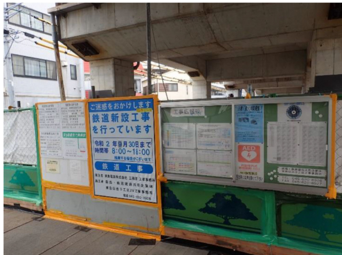
写真 2.4.4-8(2) 環境保全のための措置の実施状況（工事計画の周知：工事案内掲示板②）
