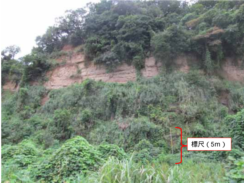
写真 6.11-1 計画地内の海食崖の状況 (現況)
