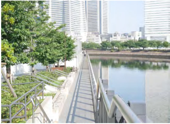
写真 3.4-3 プロムナードの利用確保の状況
