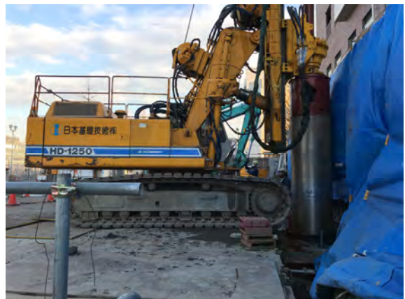
写真 3.1-12 BG工法の実施状況
