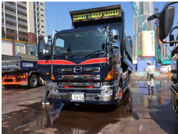
写真 3.3-3 搬出車両の状況 (タイヤ洗浄)
