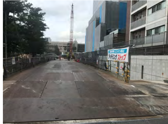
写真 3.2-2 段差のない鉄板敷の設置状況
