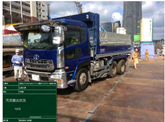
写真 3.3-2 搬出車両の状況 (飛散防止シート設置)
