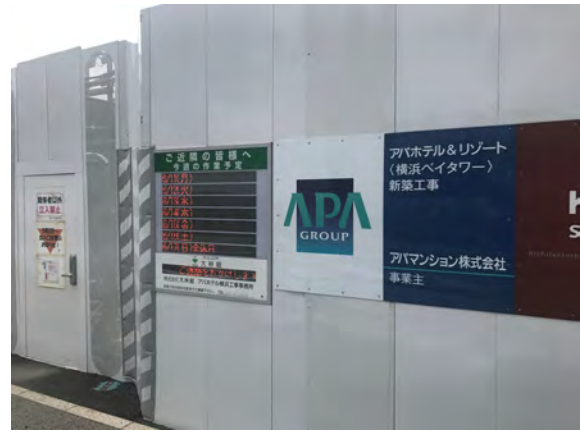
写真 3.4-4 お知らせ看板の設置状況
