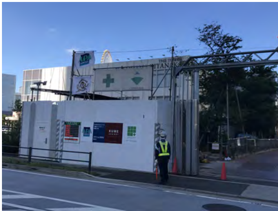
写真 3.1-9 仮囲いの設置状況
