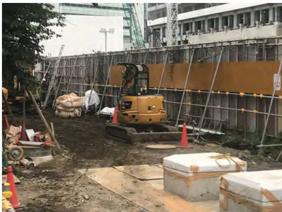
写真 3.1-5 隣地境界付近での 小型重機の使用状況
