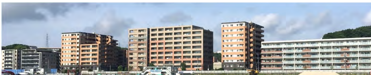
写真 2.8-1 西側マンションの概況 (外壁の色彩は、アースカラー(茶系等)や白色等が用いられている)
