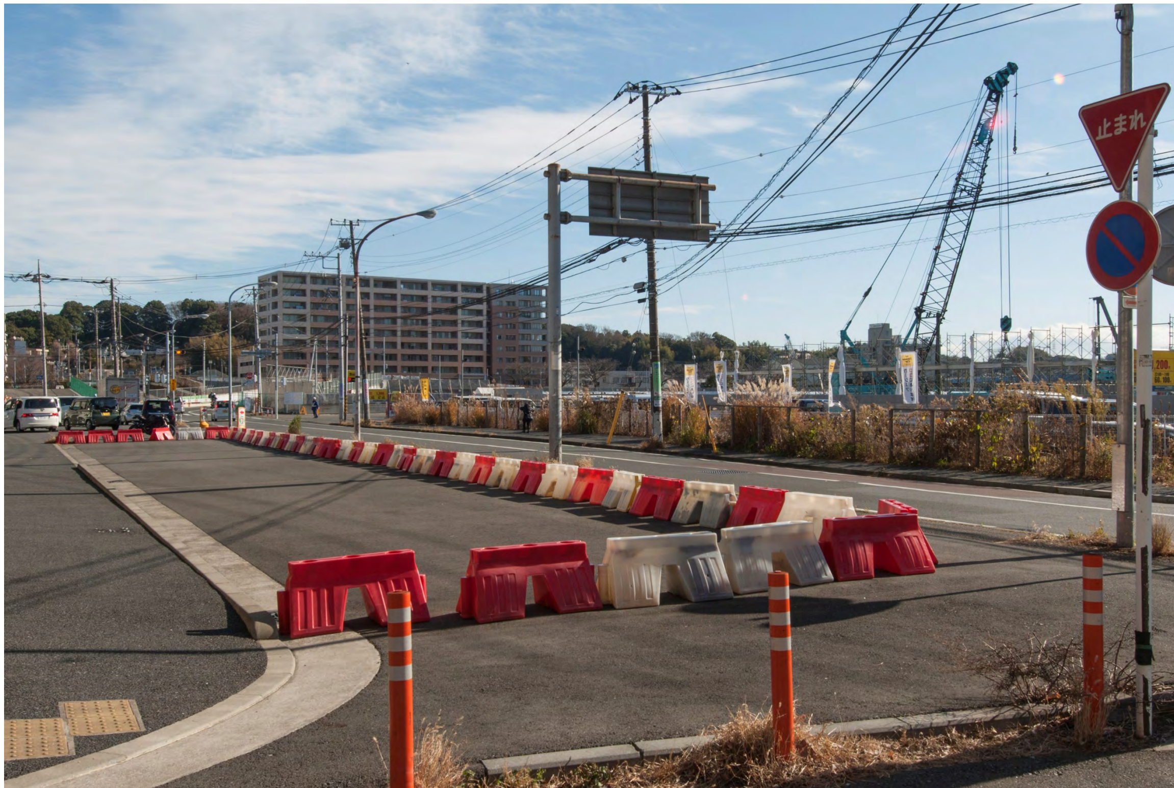
図 5-2(5) 建設前の状況写真（地点 14：西側敷地北西側（東方向を眺望））〈本編 p.6.11-30 の図 6.11-3(14) 拡大版(焦点距離 35mm 相当の画角)〉
