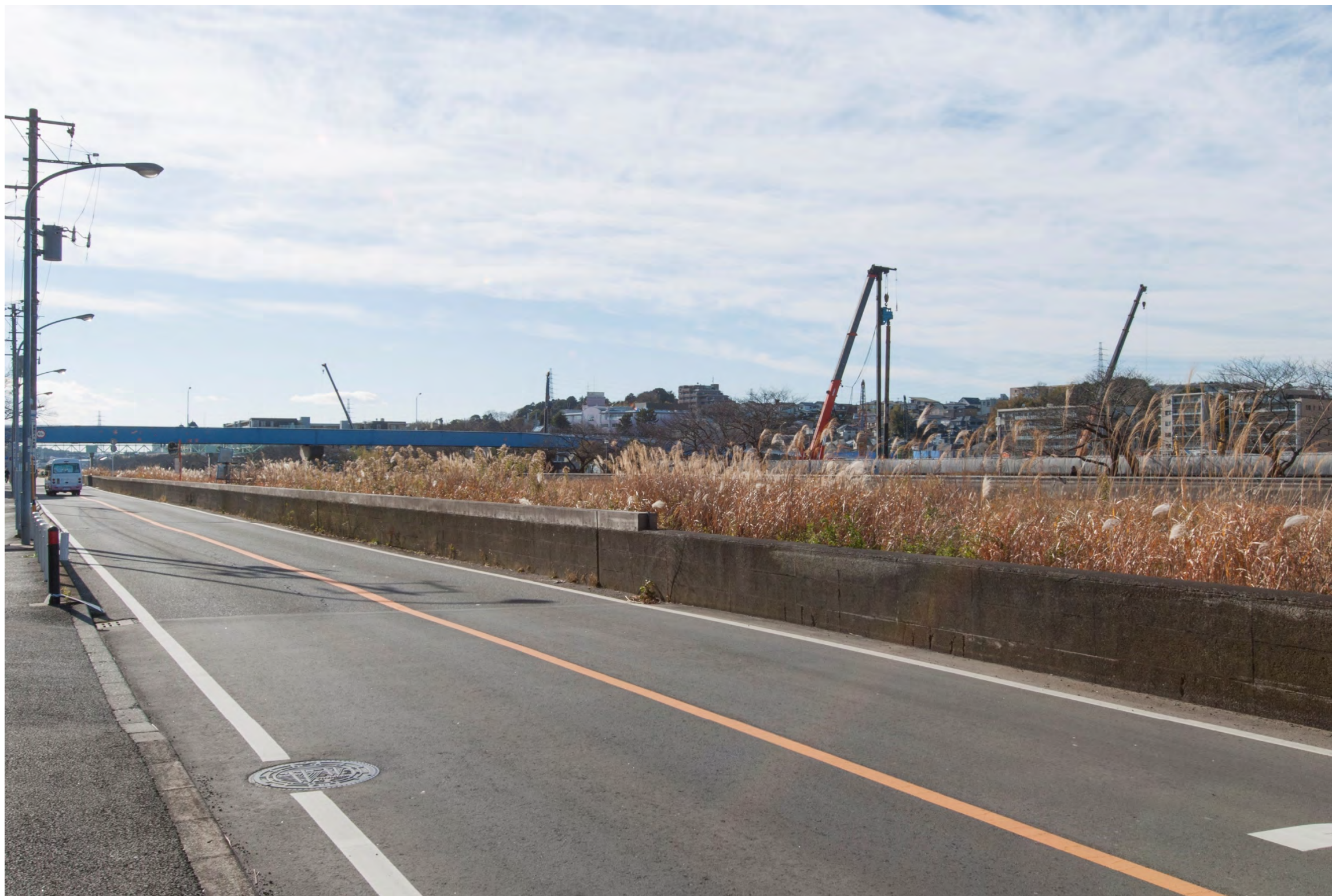
図 5-2(3) 建設前の状況写真（地点 13：高嶋橋南東側）〈本編 p.6.11-29 の図 6.11-3(13) 拡大版(焦点距離 35mm 相当の画角)〉
