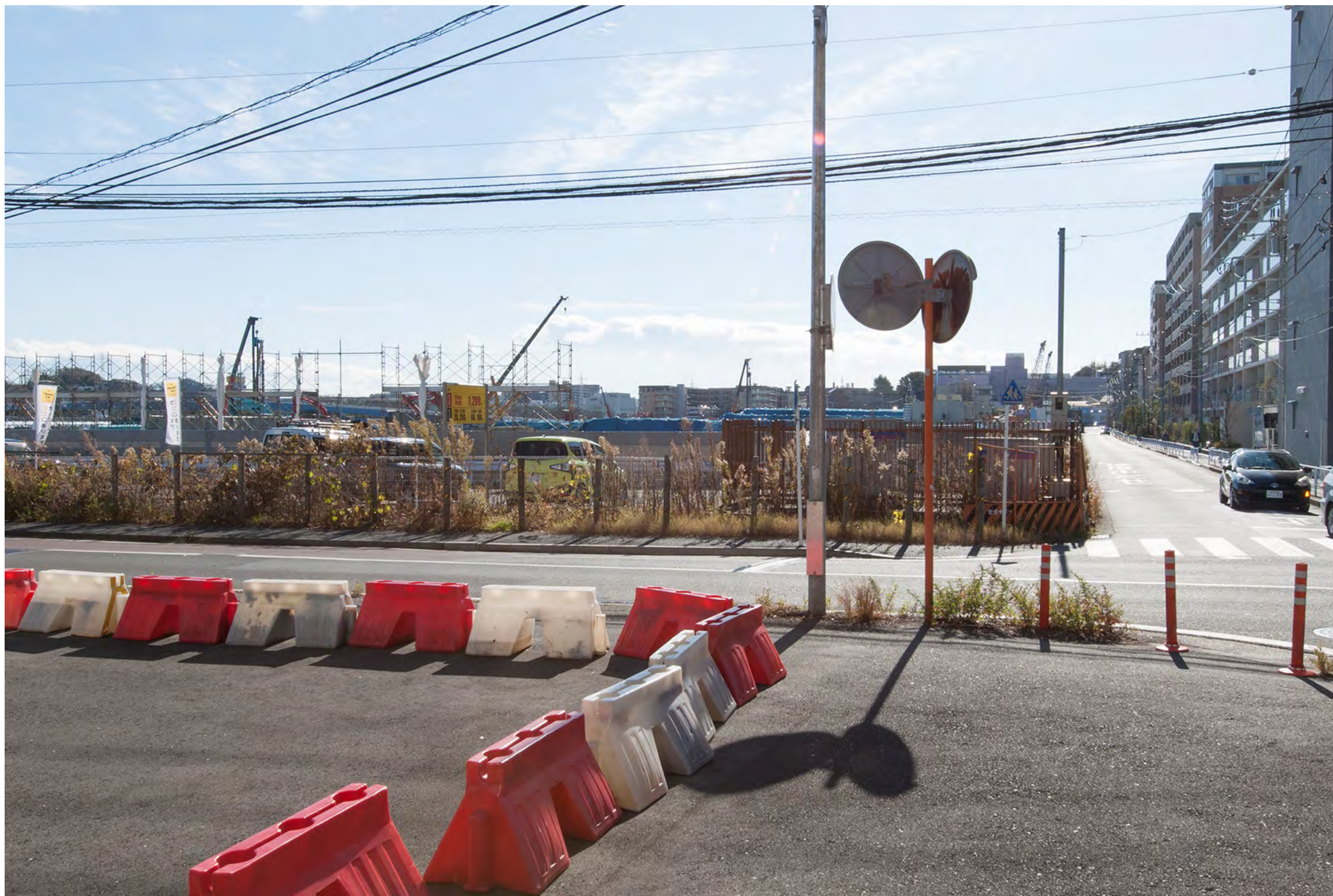
図 5-2(7) 建設前の状況写真（地点 15：西側敷地北西側（南方向を眺望））〈本編 p.6.11-31 の図 6.11-3(15) 拡大版(焦点距離 35mm 相当の画角)〉
