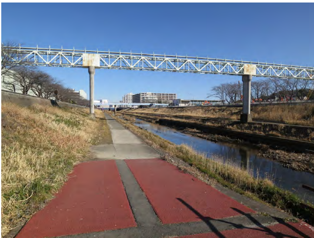
写真1.3-2 動力橋の現況写真（南側からの眺望：平成29年2月7日撮影）
