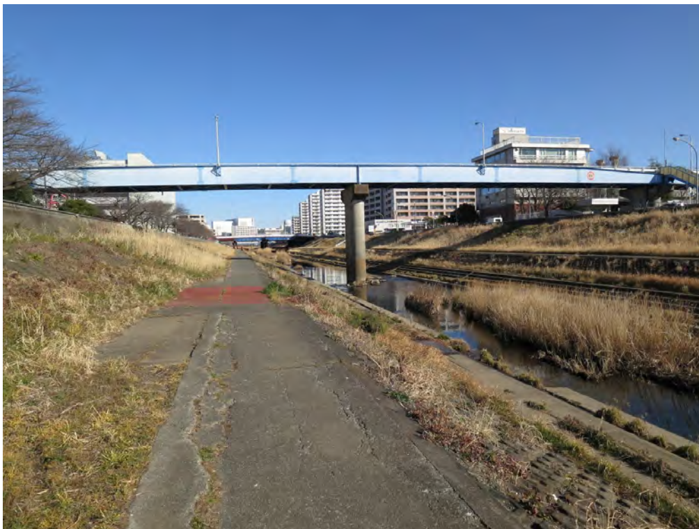
写真1.3-1 ひさご橋の現況写真（南側からの眺望：平成29年2月7日撮影）
