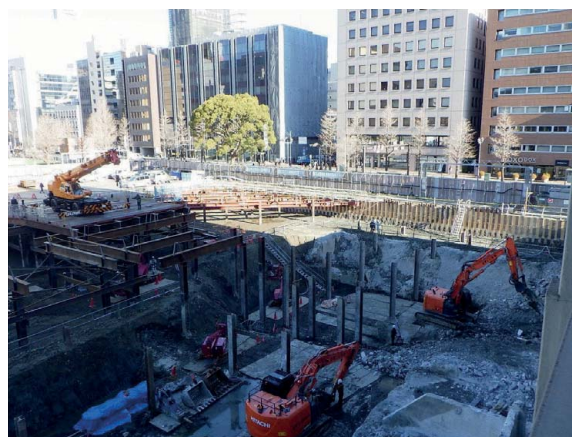
振動調査時の工事現場内
