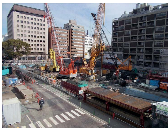
騒音調査時の工事現場内
