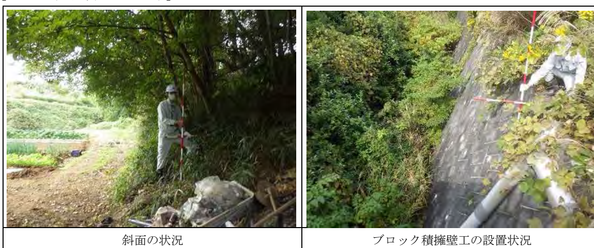
写真 9.8-1 土砂災害警戒区域の状況
