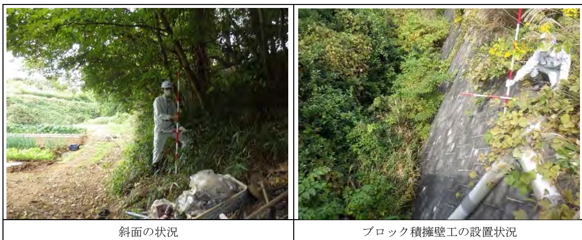
写真 9.8-1 土砂災害警戒区域の状況
