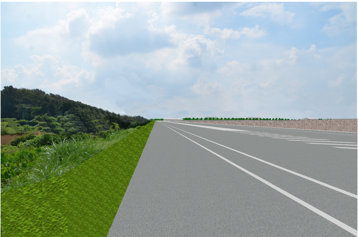
写真 1.9-1(3) No. 31 旧上瀬谷通信施設内通路（対象事業実施区域 北東側）開催中
