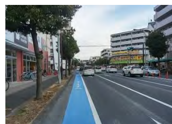
整備した自転車レーン（都筑区）
