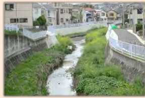
多自然川づくり
