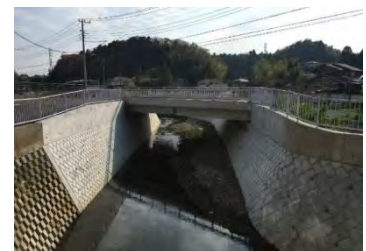
護岸整備された河川 (奈良川)
