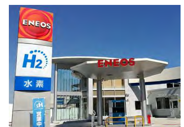
横浜綱島水素ステーション
