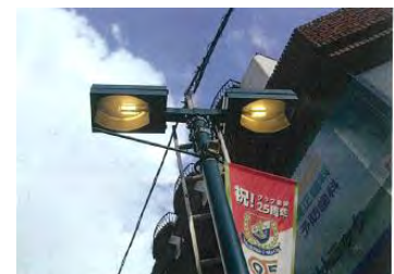
LED 照明に交換した街路灯 （綱島モール商店会（港北区））
