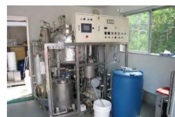
バイオディーゼル燃料を精製する設備
