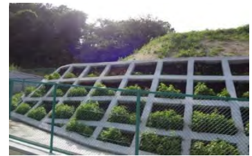
神奈川区白幡西緑地の 生物多様性に配慮した法面整備
