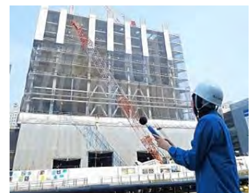
建設現場の騒音測定の様子
