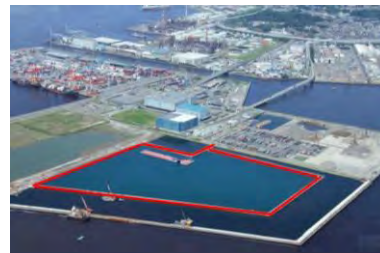
第5ブロック廃棄物最終処分場 （中区、南本牧ふ頭）
