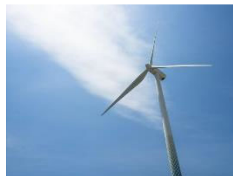
横浜市風力発電所 ハマウイング
