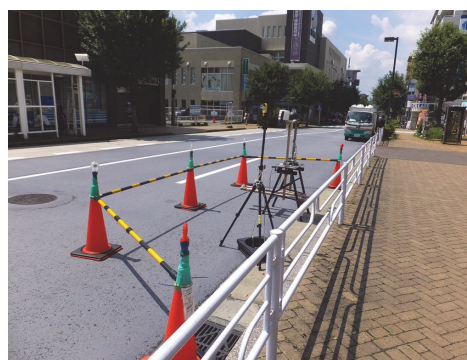
図4 測定器での観測状況 (市が尾駅前の遮熱性舗装)
