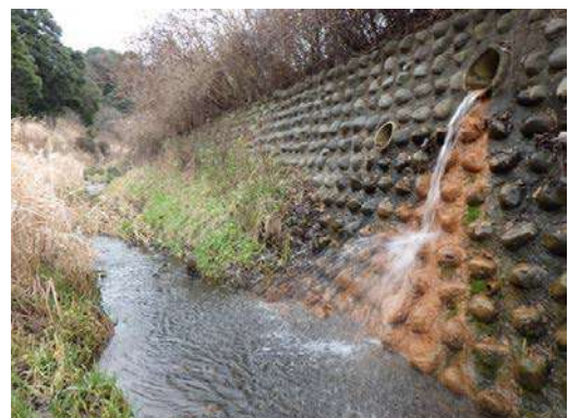
調査環境(T9 水路の流入)
