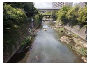
帷子川 鶴舞橋
