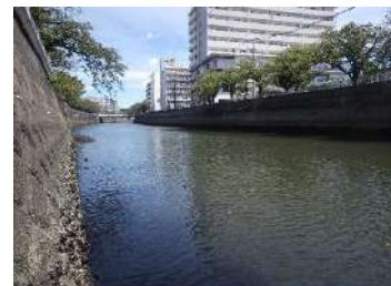
大岡川 井土ヶ谷橋
