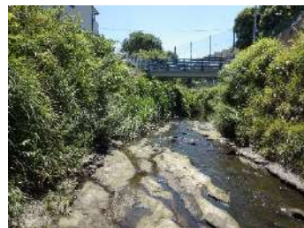
大岡川 曲田橋
