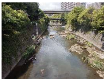
帷子川 鶴舞橋
