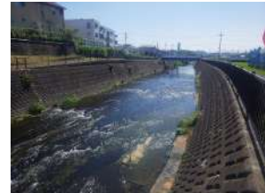
恩田川 堀の内橋
