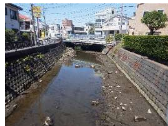
侍従川 六浦二号橋
