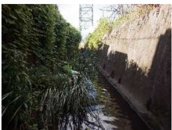
帷子川 大貫橋上流
