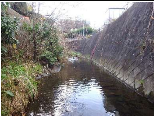
○2 大岡川 陣屋橋上流 (冬季)
