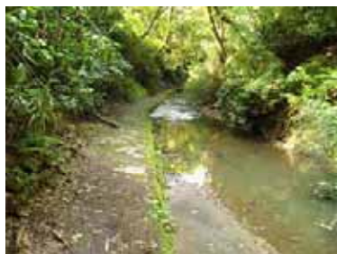
下流側の水路と散策路
