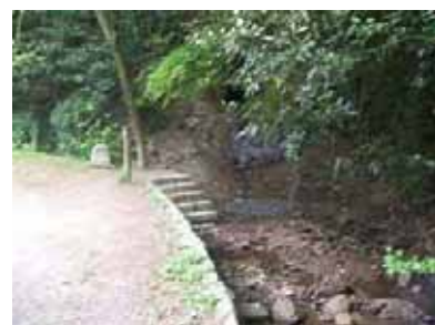
小川アメニティ（石積みの水際と階段）
