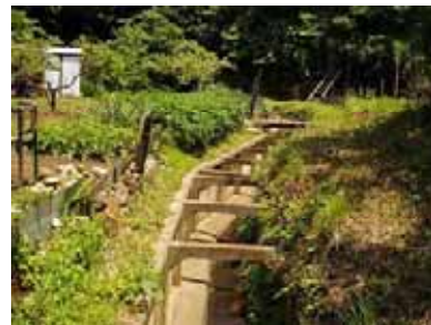
南側の谷戸開口部にある三面護岸水路
