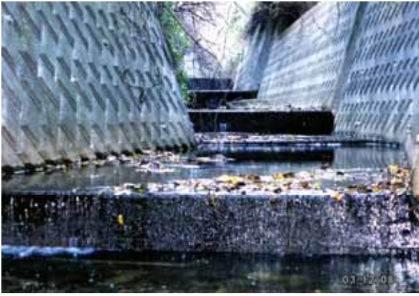
写真1 ST.5上のD2～8の多段式落差工、落差1m以上が4段であった。スミウキゴリは下から2段目まで出現していた。
