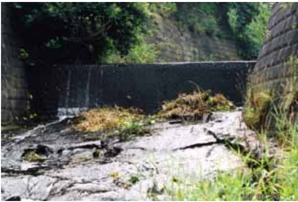
写真2 D29と岩盤、落差約3m、岩盤勾配10度、左の側壁部でスミウキゴリの遡上を確認（写真4）、アユはこの落差工下の淵まで出現した。
