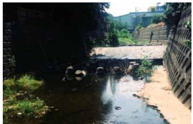
写真6 ST.6の淵下流に設置されているD27、上部が勾配20度の暖傾斜となっていた。構造物の形態によってはより多目的性を持った生息場となりうる。
