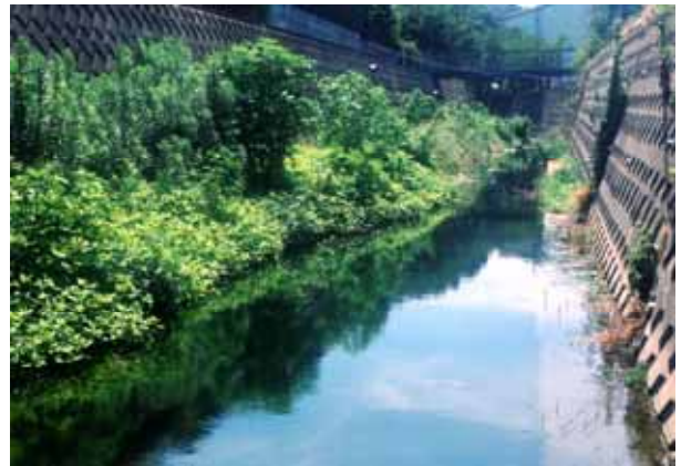
写真5 ST.6のMD型の淵、多くの魚類が出現した。上流に屈曲部、底質は自然岩盤、砂・礫、下流に堰が設置され、河原には河辺植物が繁茂する。上流方向を撮影。
