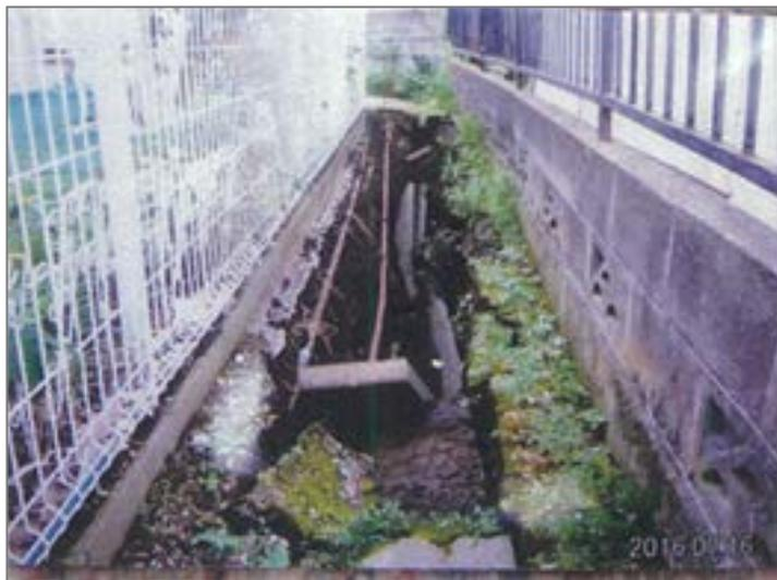
写真二 被害状況 (陥没)
