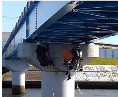
写真－ 1 高所作業による点検
