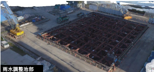
図-4 SfMによる3Dモデル(点群データ)
