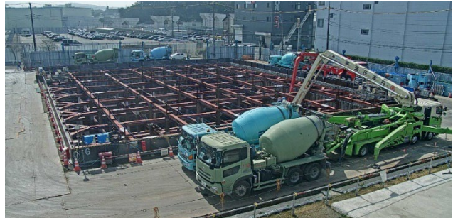
写真-3 撮影した現場写真
