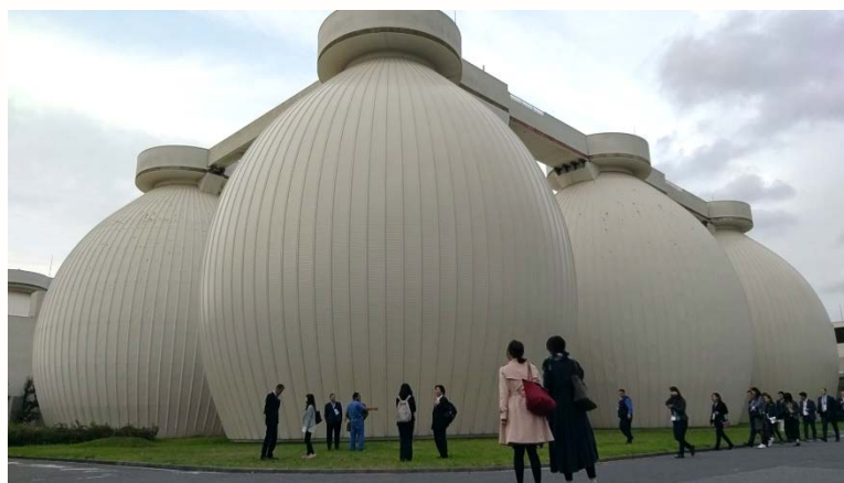
北部下水道センター卵形消化タンクの視察
