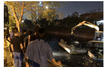
水路の底泥浚渫作業視察
