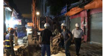
浸水対策工事現場視察
