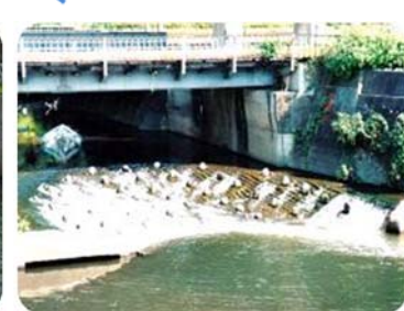
粗石付き双斜曲面式全断面魚道の整備 いたち川 (横浜市栄区)
