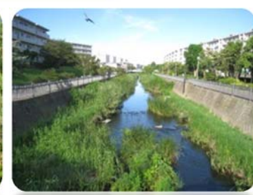
出水時の待避場所(ワンドの整備) いたち川 (横浜市栄区)
