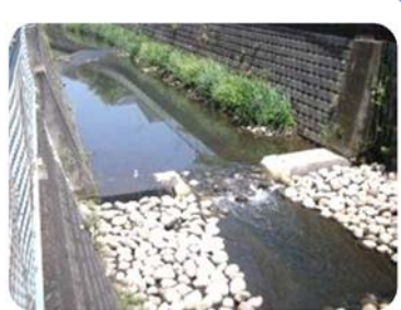
横断施設の一部切り欠き 黒須田川 (横浜市青葉区)
