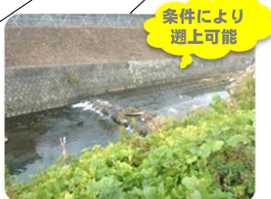
⑥公園橋下流落差工
