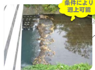
⑦公園橋上流落差工
