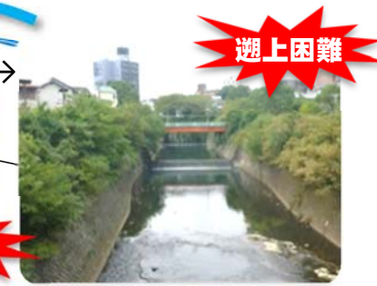
③鶴峰橋下流落差工 (H28予定)
