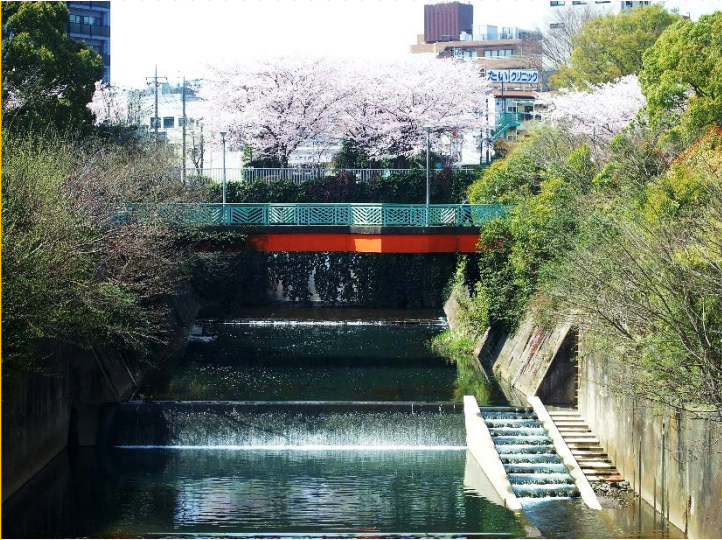
帷子川捷水路トンネル上部：旭区
