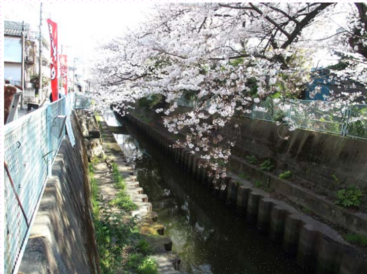
神入橋上流右岸区間：神奈川区
