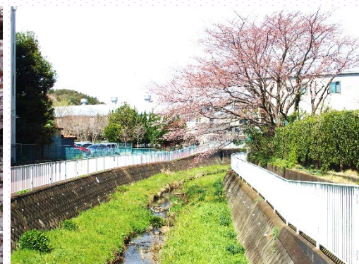
羽根沢橋上流区間：戸塚区
