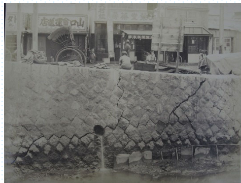
④ 石崎川（扇田橋付近の護岸の全壊）⑤ 石崎川（石崎橋付近の護岸に亀裂）⑥ 石崎川（石崎橋下流の護岸の破壊）
