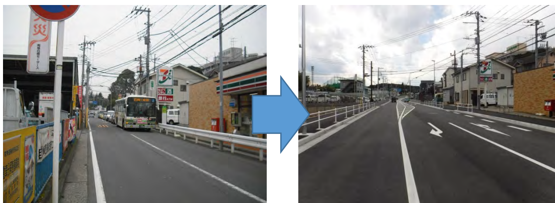
図 5-28 道路の拡幅整備（旭区）
