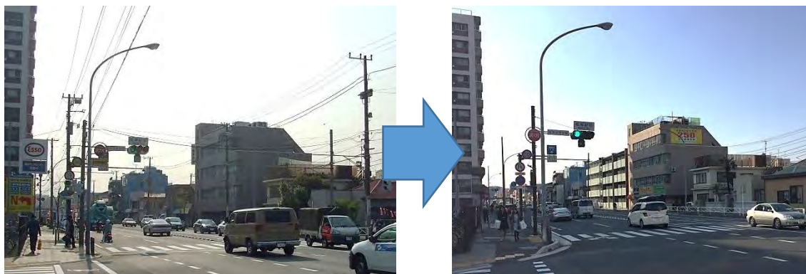
図 5-5 3 緊急輸送路の無電柱化（磯子区）
