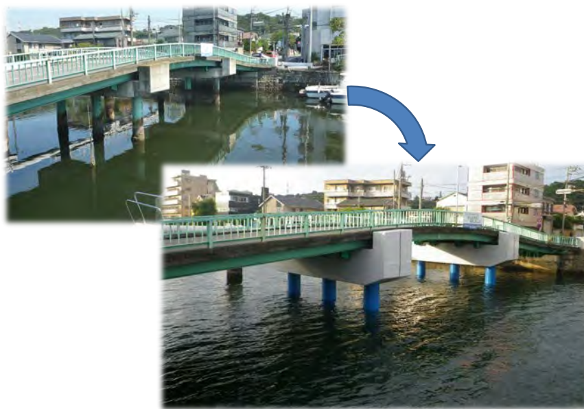
図 5-5 2 橋梁の耐震化（磯子橋）
