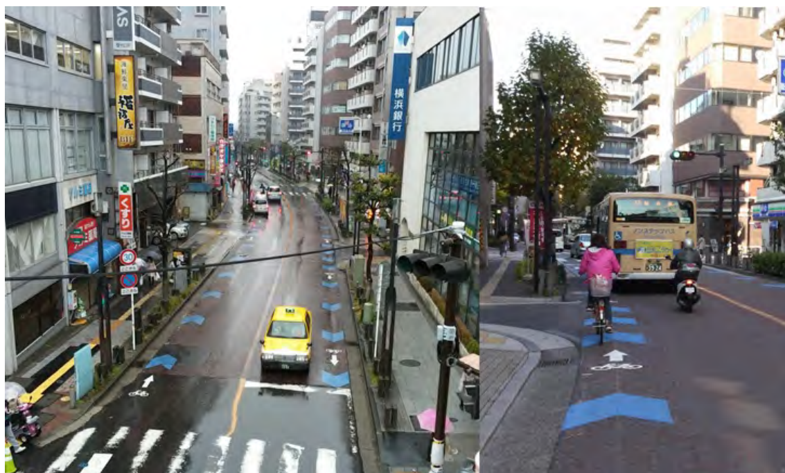
図 5-59 車道混在型（矢羽根）の設置
