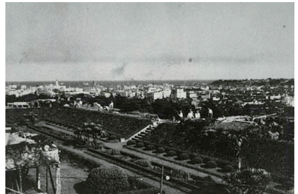
造営中の野毛山高射砲陣地。横浜の市街地が一望できる場所に築かれた(昭和12(1937)年~昭和20(1945)年)(2)
