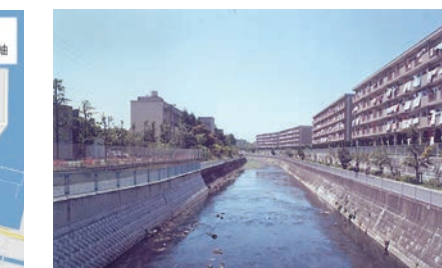
いたち川(栄区)再整備前 昭和57(1982)年
