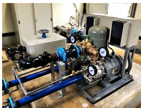
【井戸水の送水設備の更新】（戸塚区）
