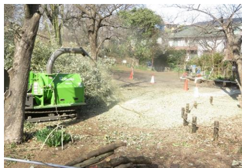
【チップ化作業支援】（青葉区）
