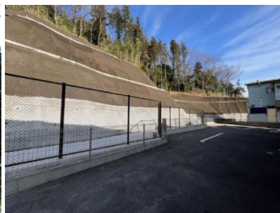
【法面の防災工事】 恩田東部特別緑地保全地区 （青葉区）
