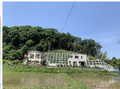
【法面の防災工事】 舞岡ふるさとの森（戸塚区）
