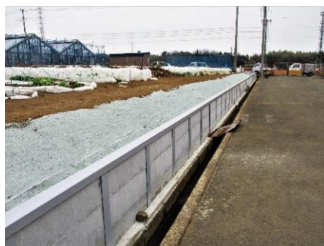
【土留め柵を設置した農地】（都筑区）
