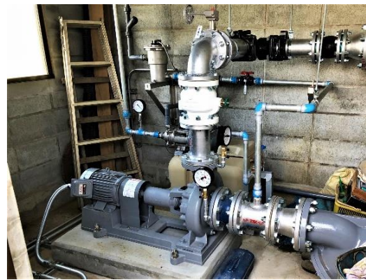
【老朽化した取水ポンプの更新】（泉区）
