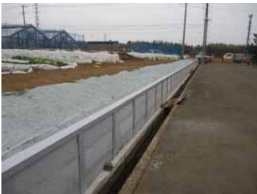
土砂流出防止対策を実施した農地 (都筑区池辺町)
