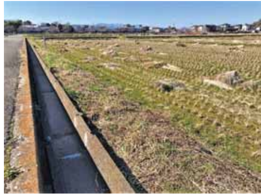
水田の用水路の修繕(泉区和泉町)
