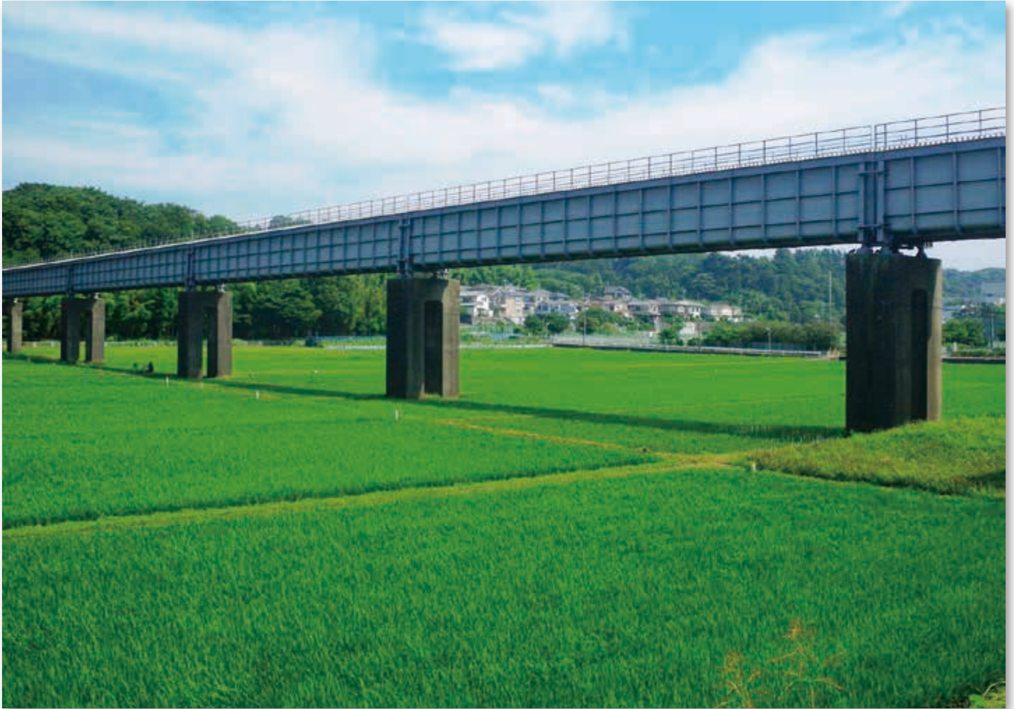
水道橋下に広がる田園風景（戸塚区東俣野町）
