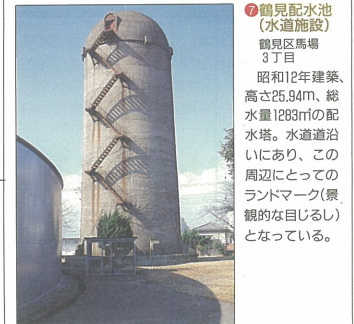
⑦ 鶴見配水池(水道施設) 鶴見区馬場3丁目 昭和12年建築、高さ26.94m、総水量1283m 3 の配水塔。水道道沿いにあり、この周辺にとつてのランドマーク(景観的な目じるし)となっている。
