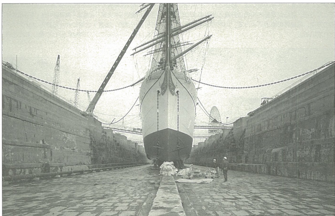
6年ぶり1度の水抜き作業中の第1号ドック
