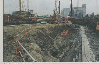
解体調査中の2号ドック
