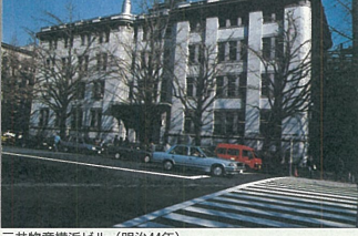
三井物産横浜ビル(明治44年)
