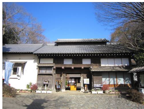
【旧大岡家長屋門】（長屋門公園） 公園として取得し、外観を保全しながら、内部は活用のために一部改修
