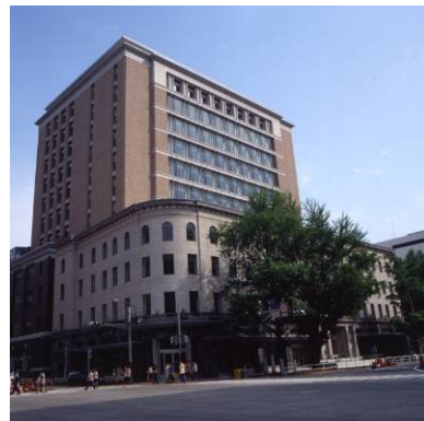
【横浜情報文化センター（一部）】 一部を保全しながら高層棟を整備。歴史的建造物躯体は再アルカリ工事実施
