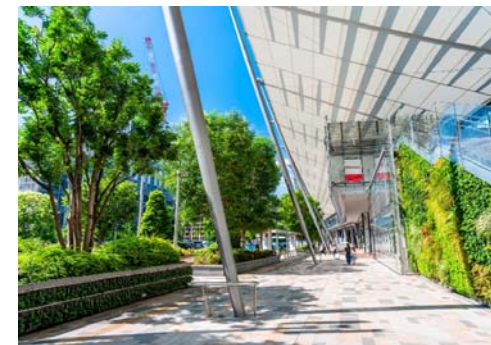
参照事例E：防風 ・日除け ビル風を避け、夏場の日陰にもなる、居心地の良い環境づくり
