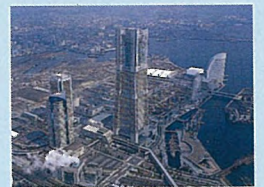
着々と進む施設建設(1994(平成6)年)
