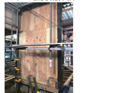
耐震補強（耐震壁の設置） 意匠を損なわないよう耐震補強を行い、建物の安全性を確保します
