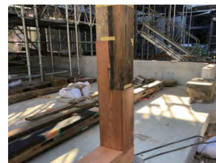
部材補修状況（根継ぎ柱） 破損・腐朽した部材も原則新規材で継ぐなど、補修を行い再利用します
