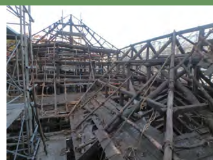
解体保管状況（小屋組） 部材はほぼ創建時のものが残っていました
