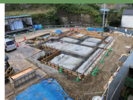
新設鉄筋コンクリート基礎（鉄筋配筋状況） 本工事では、当初基礎石を残し、その上に鉄筋コンクリート基礎を新設します
