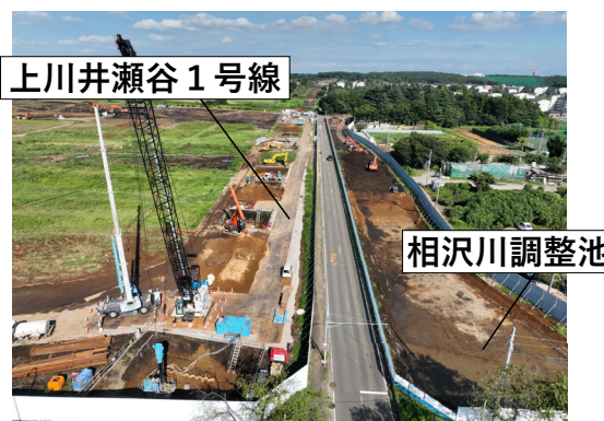
【上川井瀬谷1号線・相沢川調整池工事状況】
