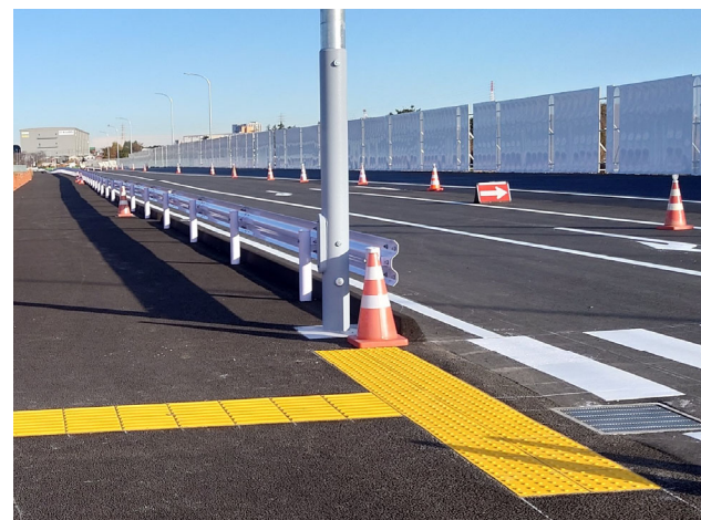
【環状4号線バイパス道路 整備状況】
