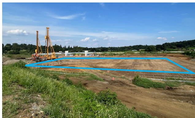
【相沢川調整池（地下式）工事状況】
