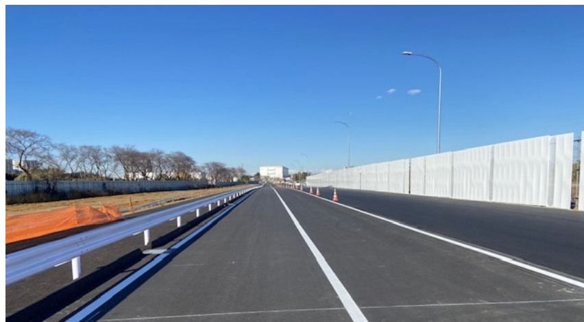
【環状4号線バイパス道路 整備状況】
