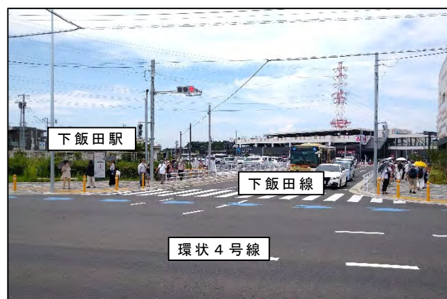
泉ゆめが丘地区 都市計画道路 環状4号線 及び 下飯田線(泉区)
