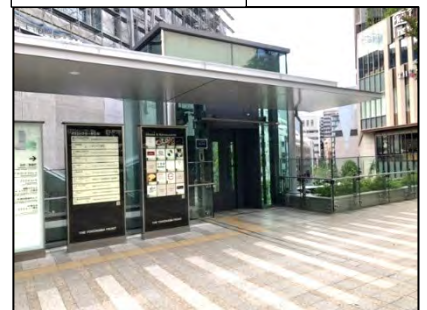
整備したエレベーター
