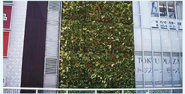
共同ビル「トツカーナ」壁面緑化
