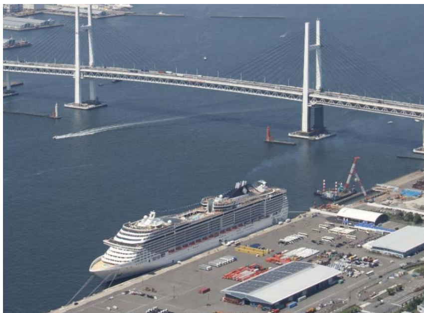
大黒ふ頭への大型客船寄港の様子
