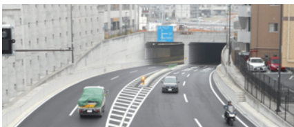
土地区画整理事業で整備した大踏切デッキとアンダーパス
